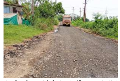
పూర్తి స్థాయిలో త్యాజంపూడి పొంగుటూరు రోడ్ నిర్మాణం త్వరితగతిన చేపట్టాలని ప్రజలు కోరుతున్నారు.
